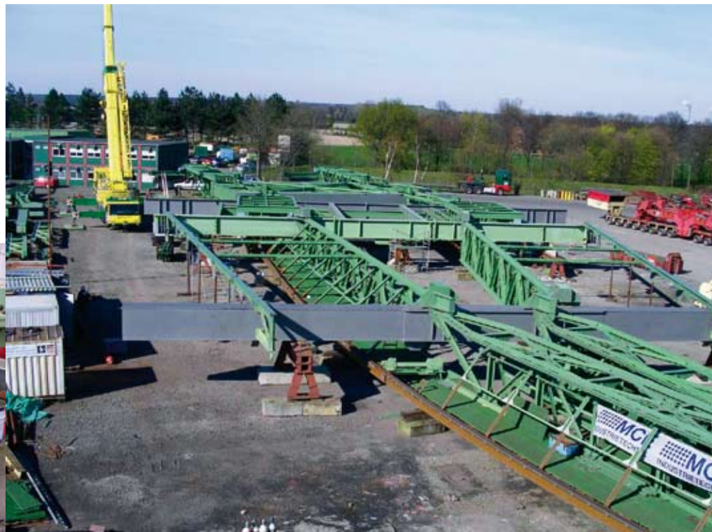
Vorzusammenbau in Moers
